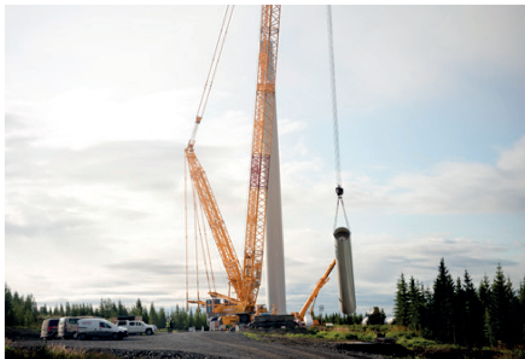
Montering av torndel Åskälen 2019.
