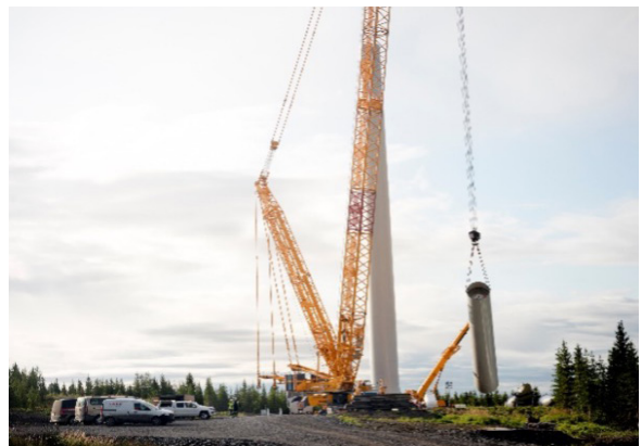
FIGUR 11 Montering av torndel i Åskälen 2019.
