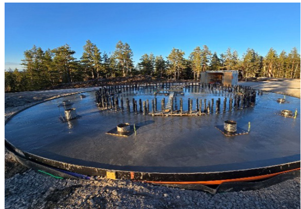
FIGUR 9 Exempel på fundament.
