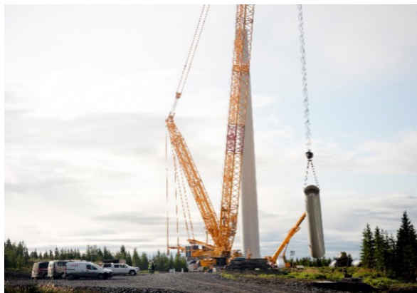
FIGUR 11 Montering av torndel i Åskälen 2019.
