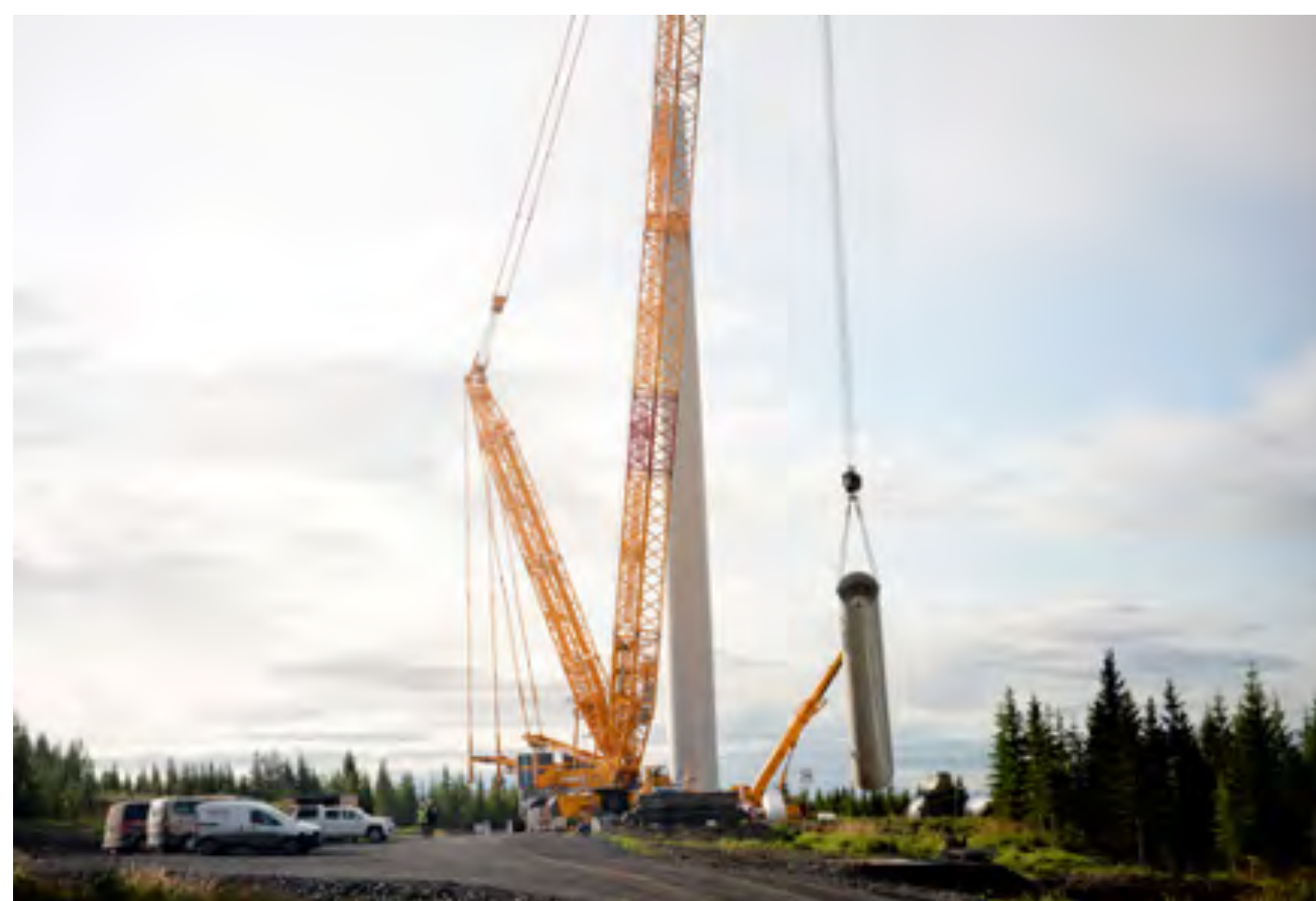
Montering av torndel Åskälen 2019.
